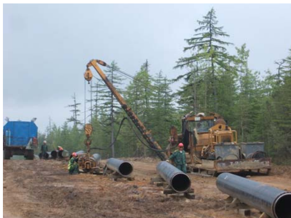
写真 1 スプレッド工法—鋼管配列と開先加工
