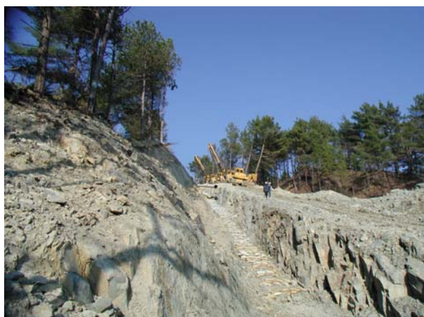
写真3 岩盤地帯の敷設
