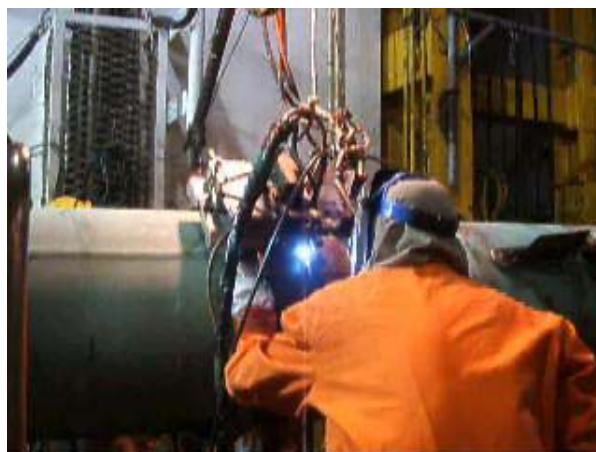
写真9 自動溶接施工（海外・海底パイプライン）
