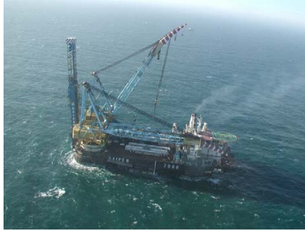
写真 8 大型敷設船による J-レイ施工
