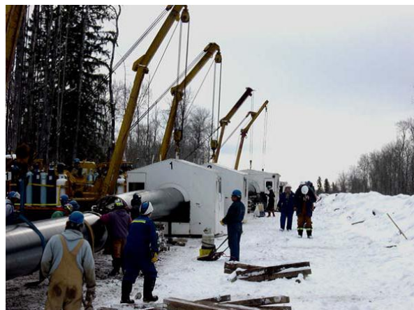
写真 2 スプレッド施工状況 — 溶接施工
