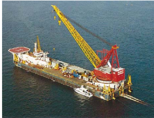
写真7 専用敷設船による施工
