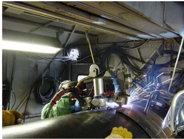
写真6 自動溶接施工(陸上パイプライン)
