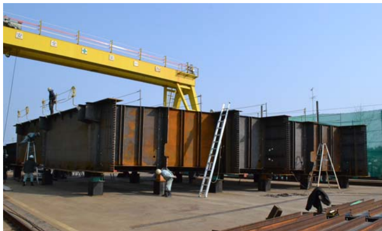
製作中の橋梁
