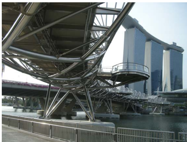
著者が訪れた東南アジア地域の建築物、 ファブリーケーターの風景
