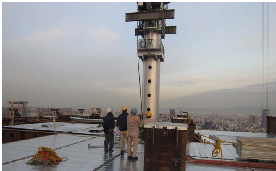
超高層ビルの建築現場を見学し、決意を新たにしている筆者達
