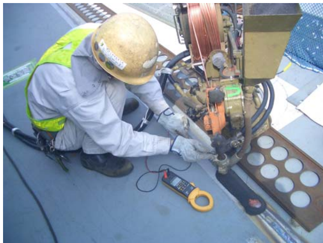
▲WES 資格保有者は現場における施工管理ならびに品質管理に欠かせない（橋梁桁現場溶接のもよう）
