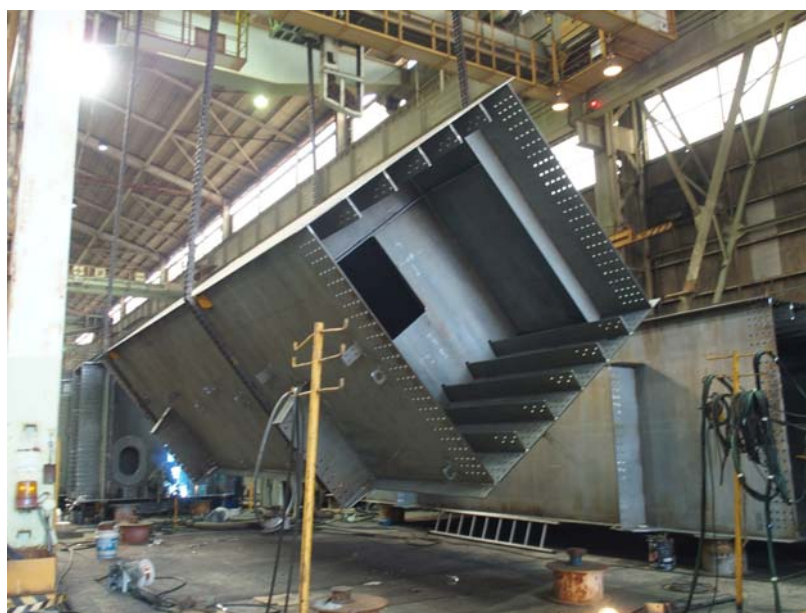
製作中の橋梁部材
