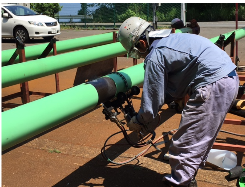
図 6 工事現場における鋼管のガス切断作業
