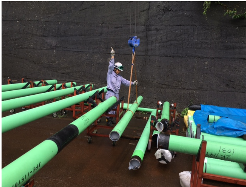
図7 工事現場における玉掛け作業
