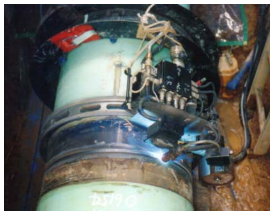
図1 パイプラインの溶接
