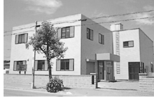
認定事業所となる地区溶接技術検定委員会 北海道地区検定委員会
