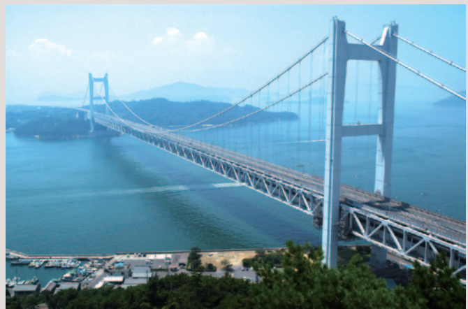
▶「瀬戸大橋」開通30周年を迎え、維持管理の徹底で劣化への対策を図る
