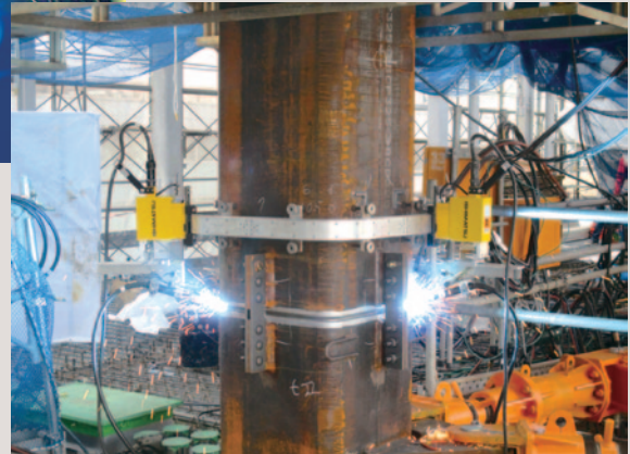
▶鉄骨柱・梁の溶接作業の全てを自動化する「現場ロボット溶接工法」開発される(大林組)
