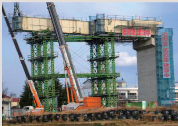
▲ 東日本大震災から7年。鋼橋などインフラ整備が着実に進行。写真は相馬福島道路の桑折高架橋
