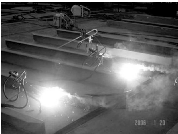
図9 グラビティ溶接
