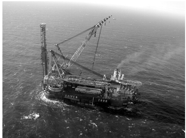
写真6 大型敷設船による J-レイ施工 Saipem 7000 (Photo by S. Nikitina)
