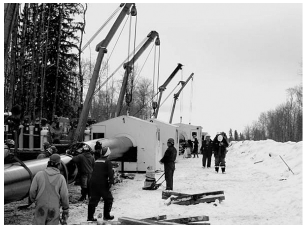
写真4 スプレッド施工状況-溶接施工
