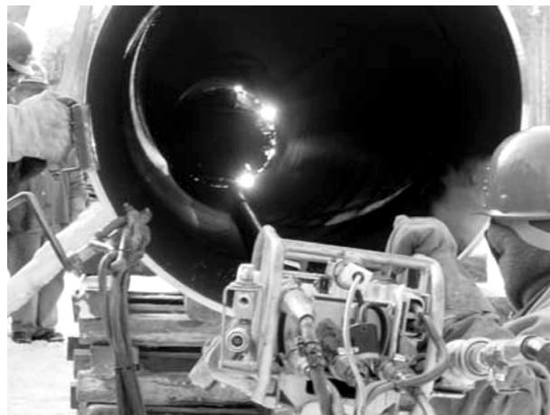
写真13 内面自動溶接施工（海外・陸上パイプライン）
