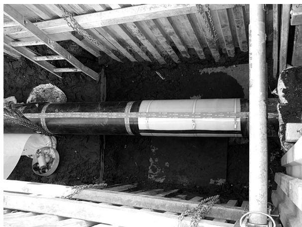
写真1 一般埋設部の開削工法
