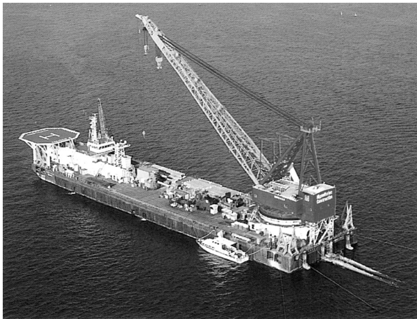
写真5 専用敷設船による施工
