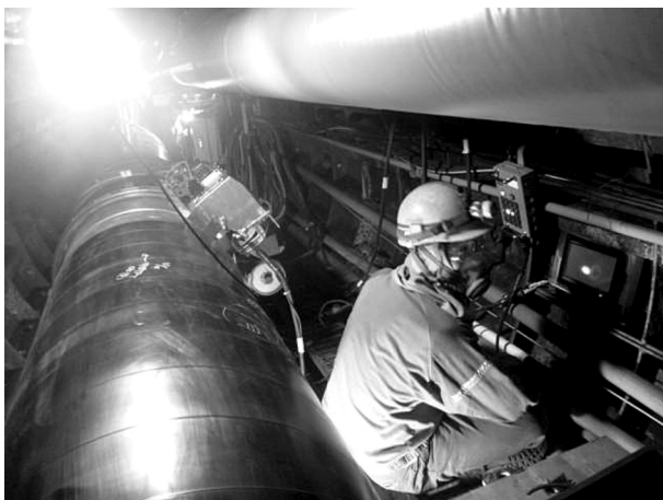
写真12 自動溶接施工（シールド工法）
