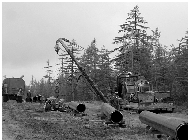
写真3 スプレッド工法-鋼管配列と開先加工
