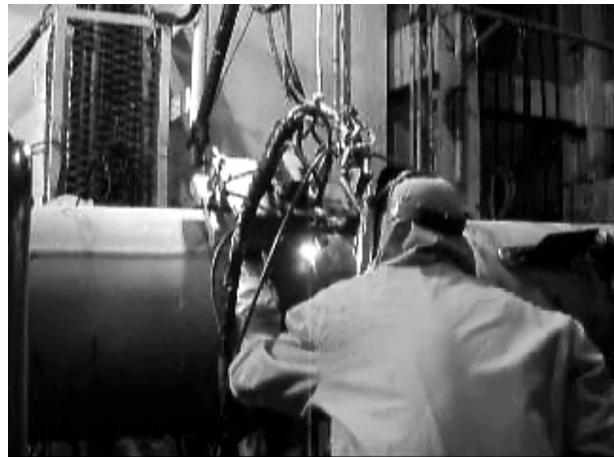
写真15 自動溶接施工 (海外・海底パイプライン)
