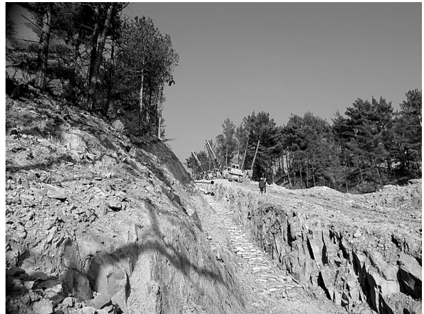
写真2 岩盤地帯の敷設 (Photo by S. Nikitina)
