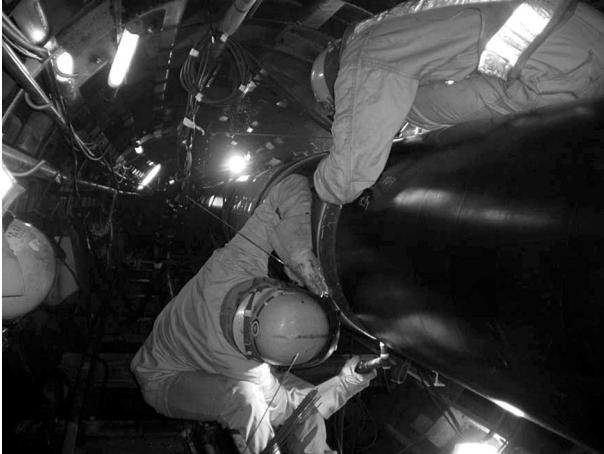
写真8 初層ティグ溶接（シールド工法）
