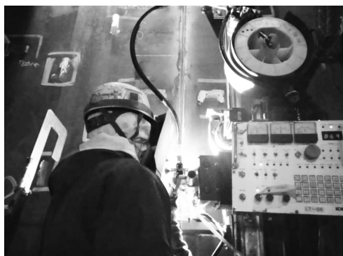
図14 自動ティグ溶接の溶接状況
