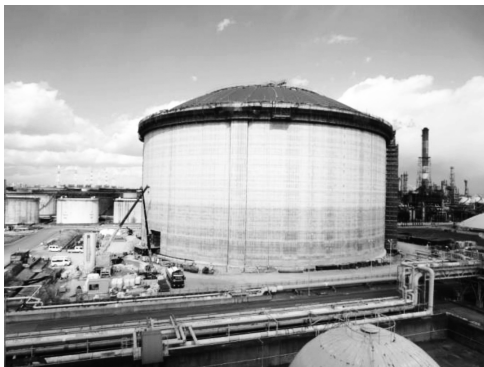
図 4 建設中の LNG 貯槽外観
