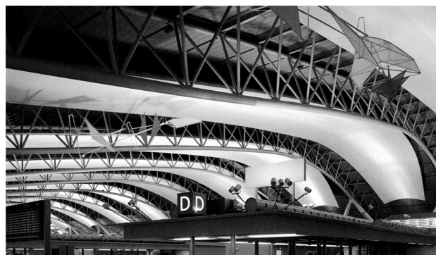
写真1 大スパンの湾曲トラス構造
