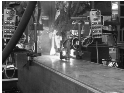
写真5 サブマージアーク溶接
