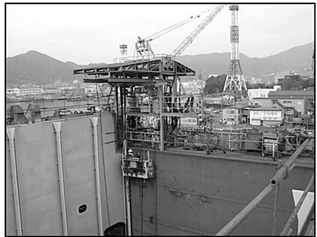
図18 船側内外板へのエレガス溶接適用例
