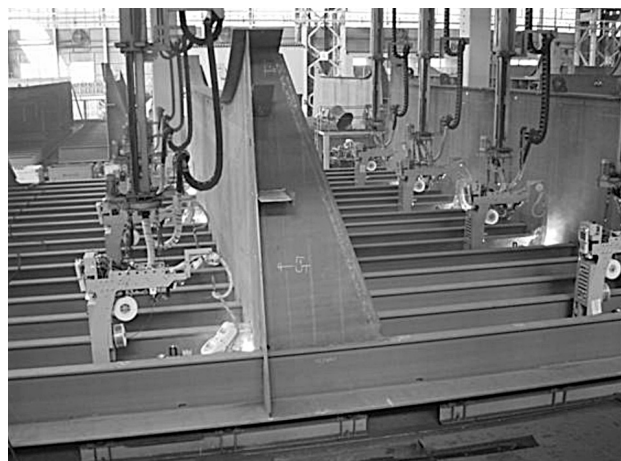
図14 ロボット溶接施工事例
