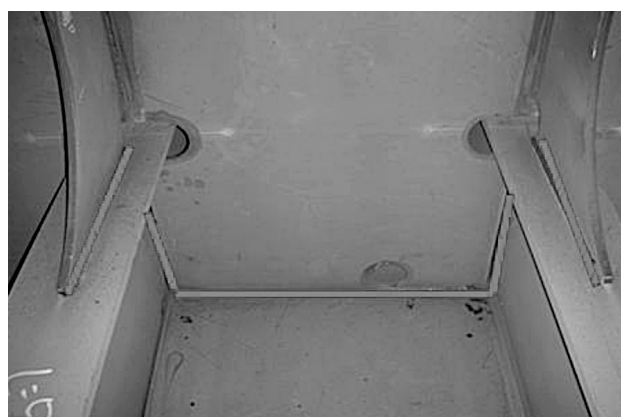
図15 ロボット溶接適用箇所
