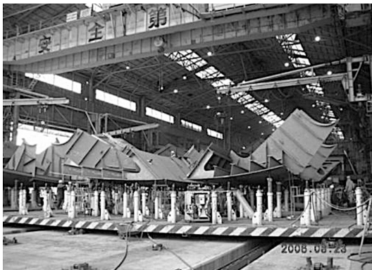
図17 曲りブロック組立工程
