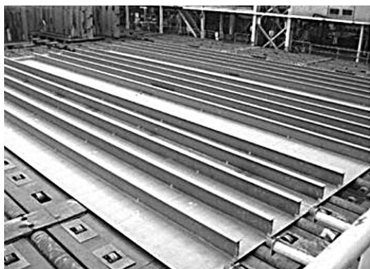
図6 単板後板継溶接
