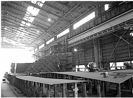
図16 曲りブロック板継ぎ工程
