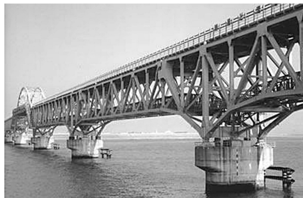
図5 荒川放水路橋 (トラス橋：東京都，1985年)
