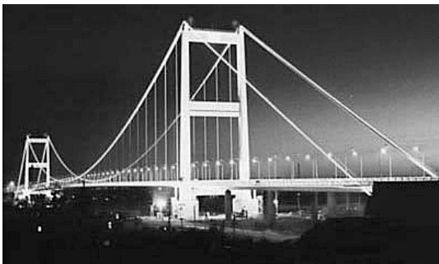
図2 イルティッシュリバー橋 (吊橋：カザフスタン，2000年)
