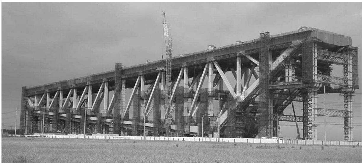
図5 現場溶接の状況
