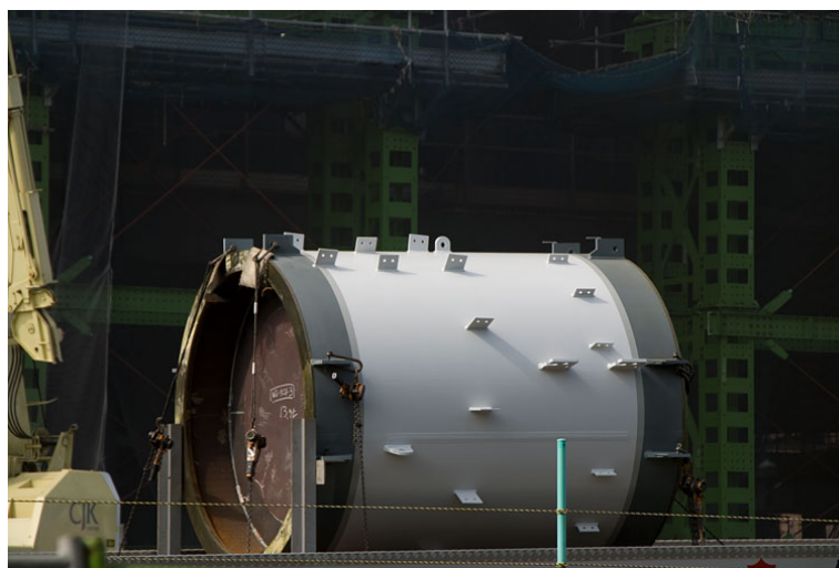
図2 塔体下部(鼎トラス)のYS500MPa級鋼管 2)
