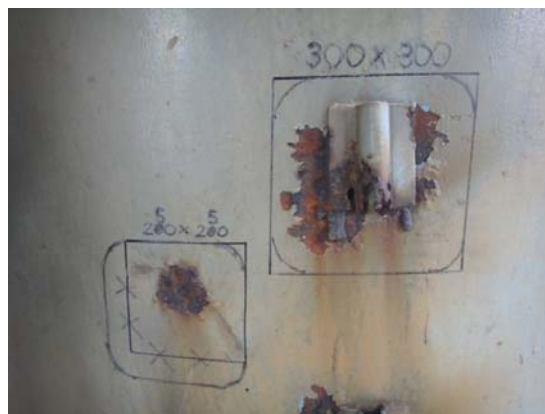
図 5.2 当板溶接箇所
