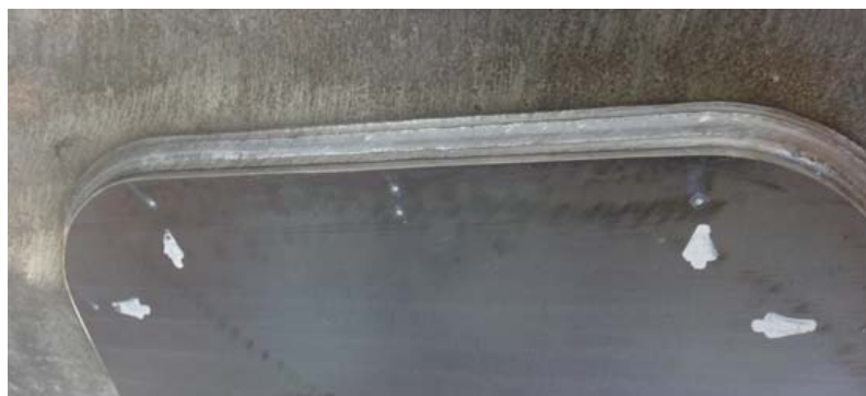
図 5.5 溶接ビード拡大
