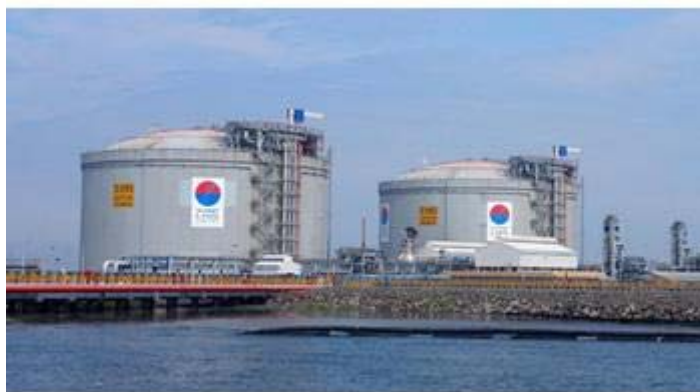
図1 インドで日本企業が建設したLNG貯槽の外観(PC-LNGタンク)
