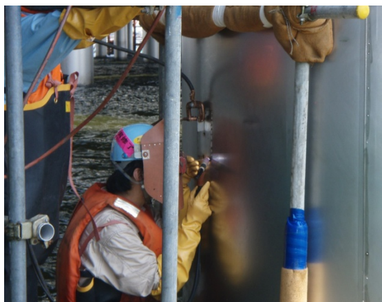
図 17 現地での補修溶接施工状況（実証試験）
