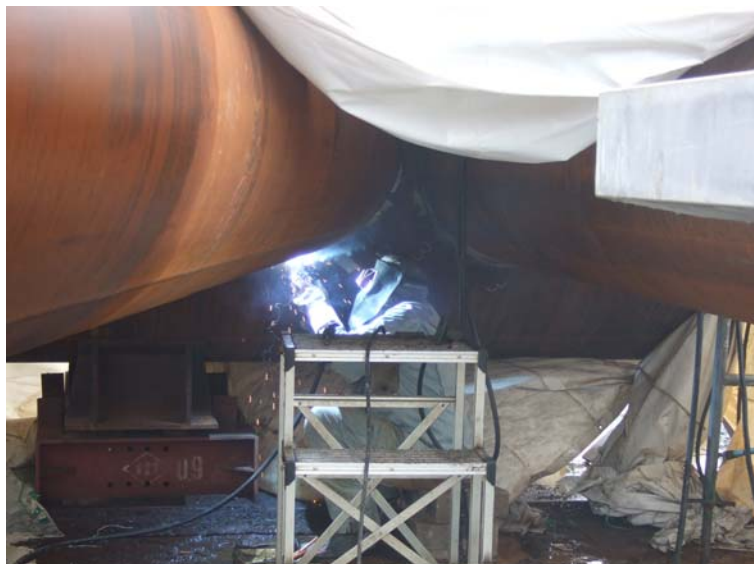
図12 下部ジャケットTKY継手部溶接状況
