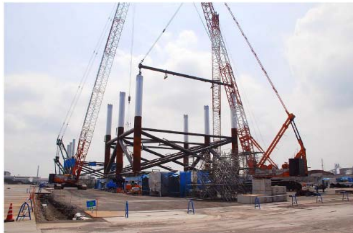
図 11 下部ジャケット組立状況
