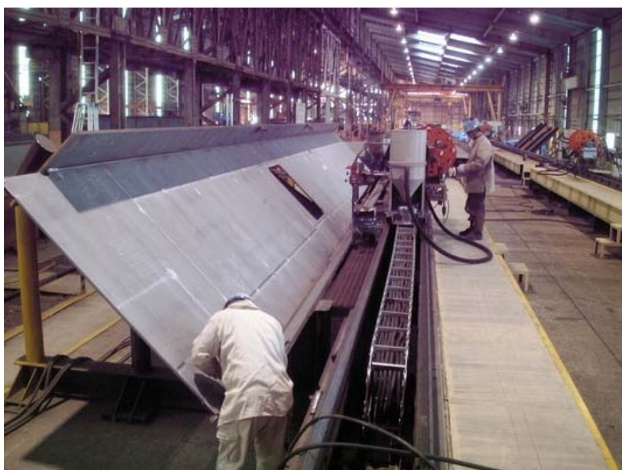
図 7 首溶接部施工状況
