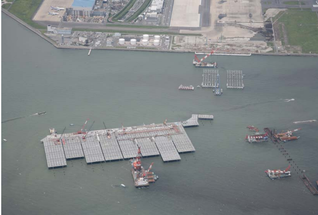
図3 ジャケッ43基据付状況
