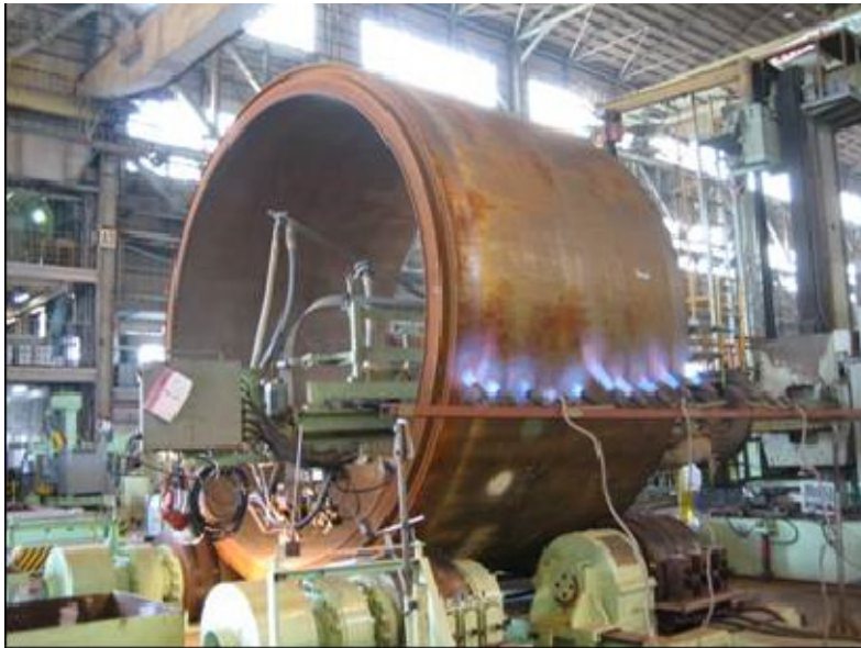
図 8 内面オーバーレイ施工の様子
