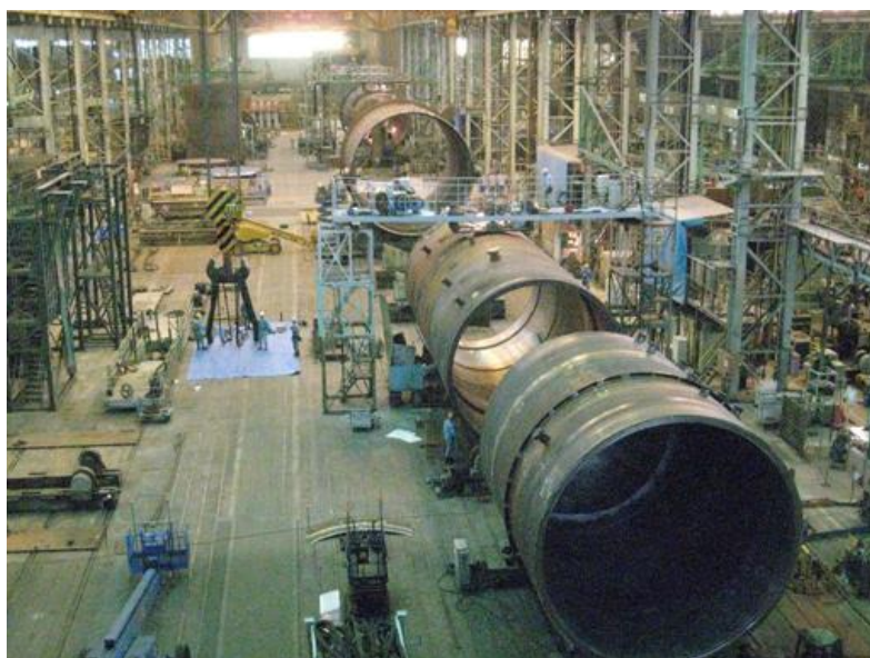
(a) 溶接状況（全景）
