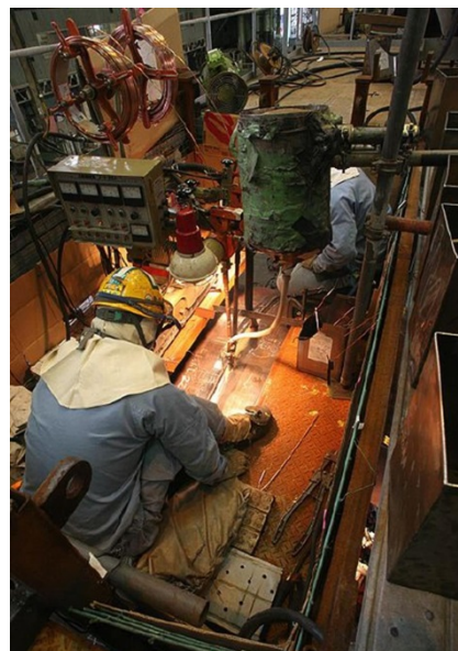
(b) 溶接状況（作業場所近傍）
