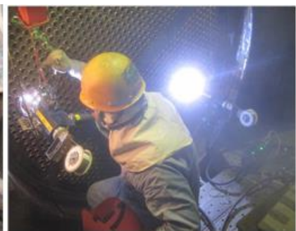
(e) 溶接状況 (作業場所近傍)
