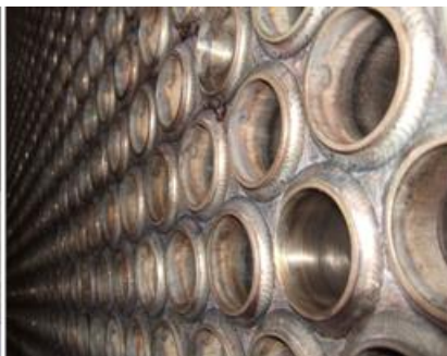
(d) 溶接部外観
