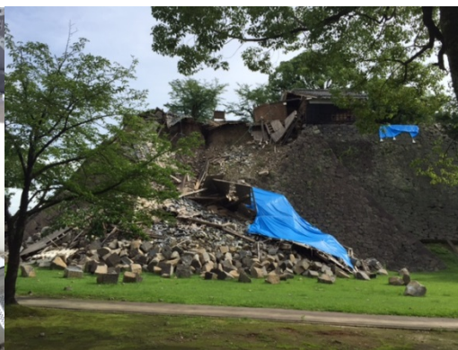
写真2 熊本城の石垣の崩壊
