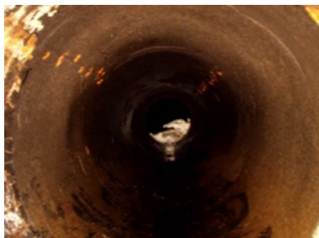
写真2 抜水直後の放流管内面(ヘドロ付着)
