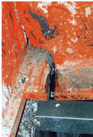
図2 阪神大震災における梁下フランジ端部からの破断
