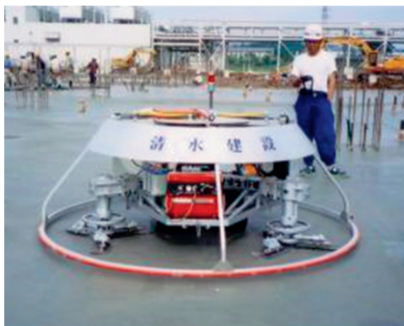
図4 コンクリート床仕上げロボット
