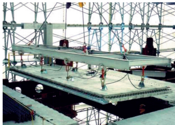
図10 プレハブ化された床スラブ
