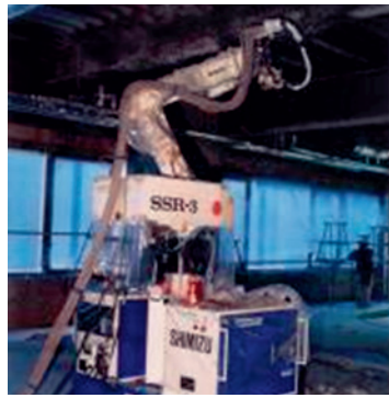
図6 耐火被覆吹付ロボット
