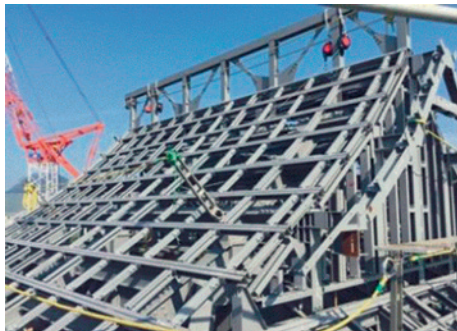
図 13 熊本城大天守 6 階鉄骨造
