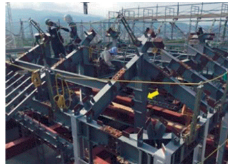
図 14 建て方中の大天守 6 階鉄骨造 (矢印：超狭開先 J-STAR® 溶接が適用された溶接四面ボックス柱)
