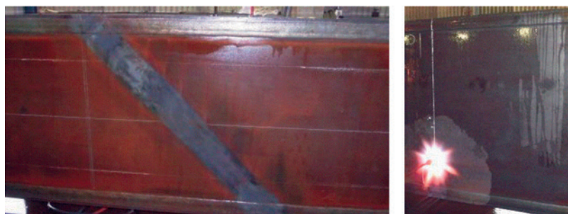
図9 溶接四面ボックスの加熱矯正作業
