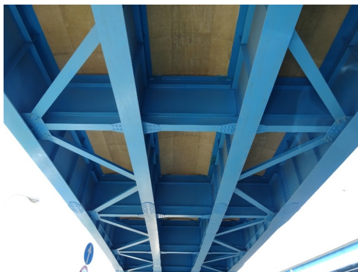
図3 多主桁橋（下面）
