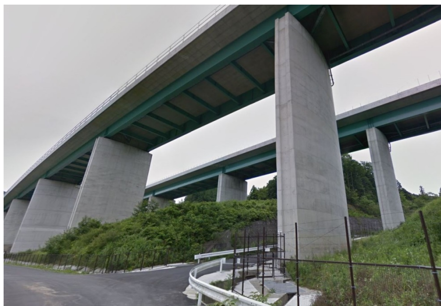
図 1 少数主桁橋（外観）
