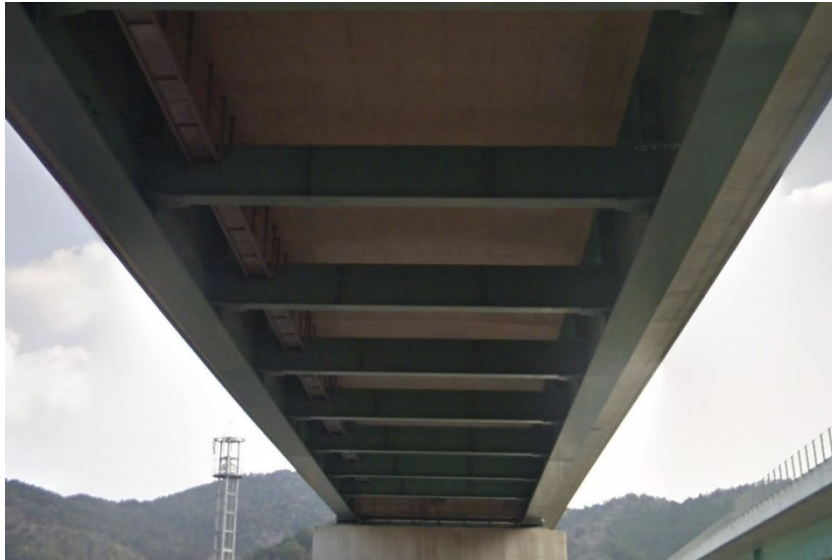
図5 少数主桁橋（下面）
