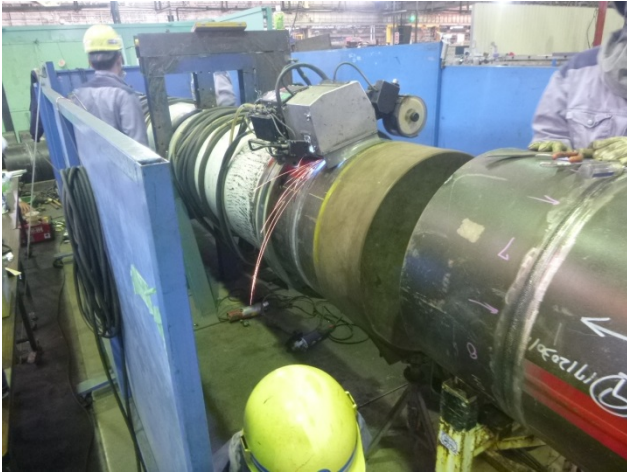
図 8 溶接施工法確認試験（自動マグ溶接）
