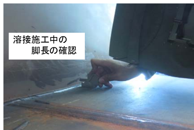
(b) 溶接施工中の脚長の確認
