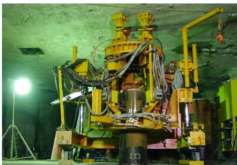
鋼管杭FW機。「アンダーピーニング（基礎・杭の補強工事）の 工期短縮を目的に、溶接・圧入機能を一体化した装置を開発した」
