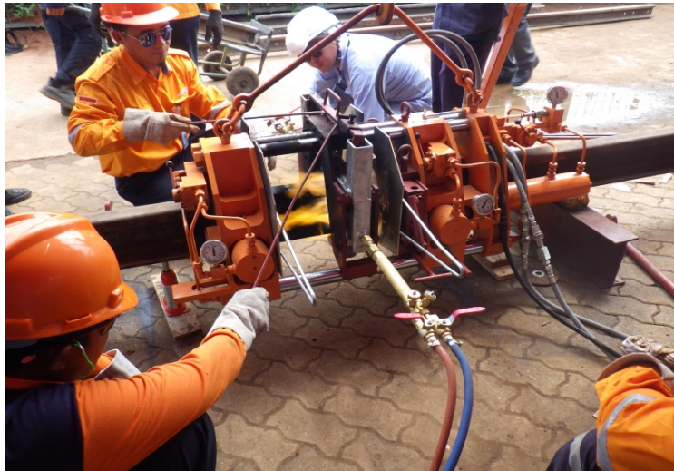
ガス圧接機（インドネシア納入・訓練）。「適用レールが UIC54 レールで日本（JIS60kg、JIS50N レール）と異なるため、ガスバーナー形状、押し抜きバイト形状の設計に苦労した」（藤井氏）
