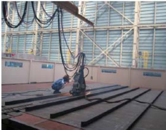
溶接施工状況
