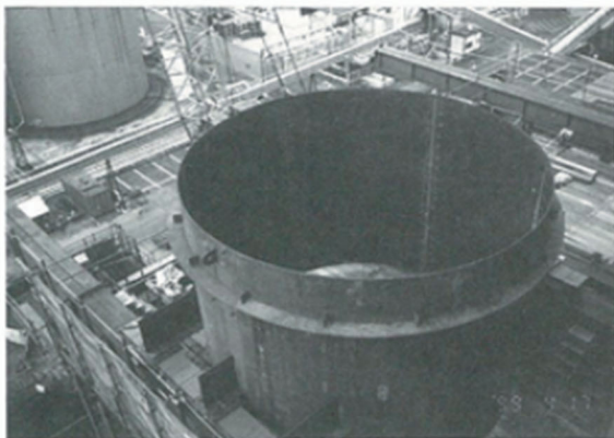
図6 マイクロドローリによる 胴板更新部分の引き込み
