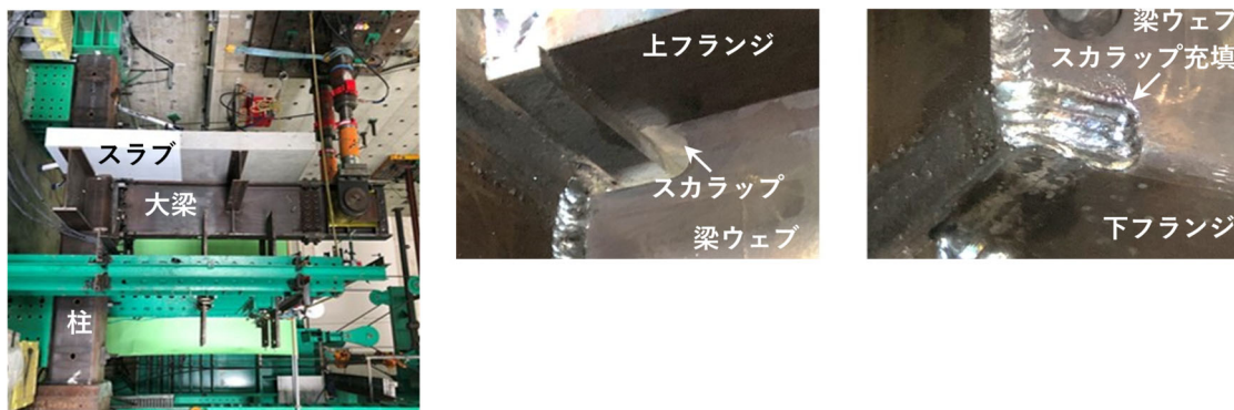
図 6 スカラップ充填を下フランジのみとする工法の構造実験
