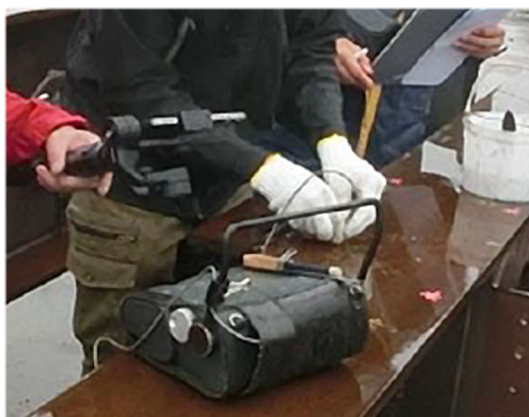
図3 第三者超音波検査状況
