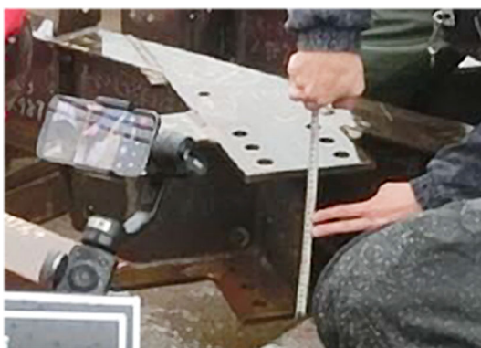
図1 寸法検査状況
