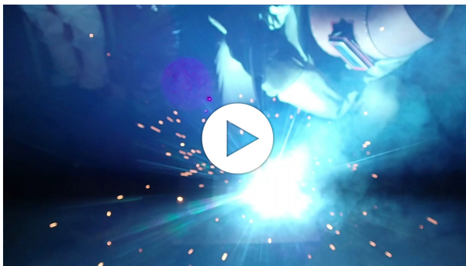
図 8 溶接中の様子 (炭酸ガスシールドアーク溶接、パルスガスマグ溶接)
