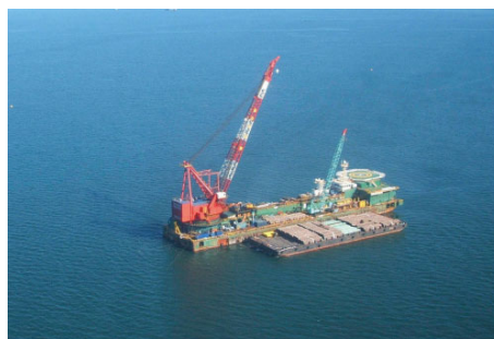
図1 海底パイプライン敷設船
