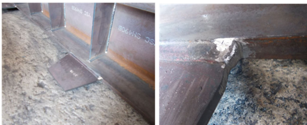
図 11 面内ガセット止端仕上げ状況図
