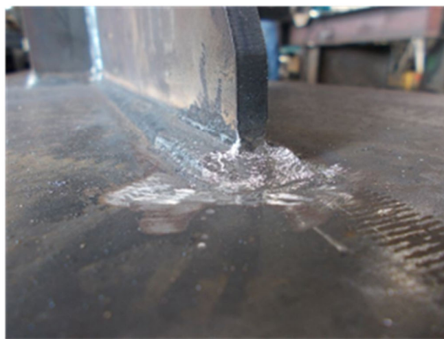
図 10 面外ガセット溶接部仕上げ状況
