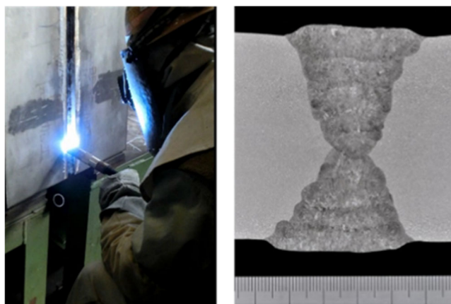
図8 溶接トーチの運棒状況（左）と溶接継手断面マクロ（右）
