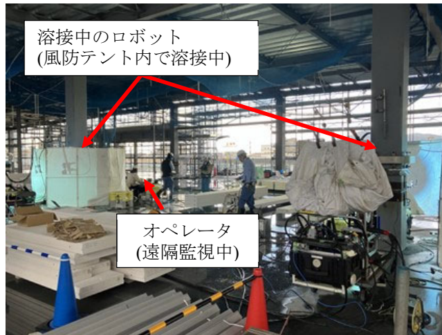
図 12 現場での 2 台同時溶接状況
