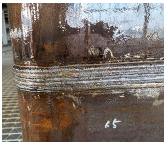
図10 現場溶接ビード外観
