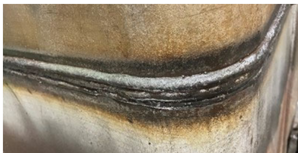
図 11 少パス溶接施工 ビード外観
