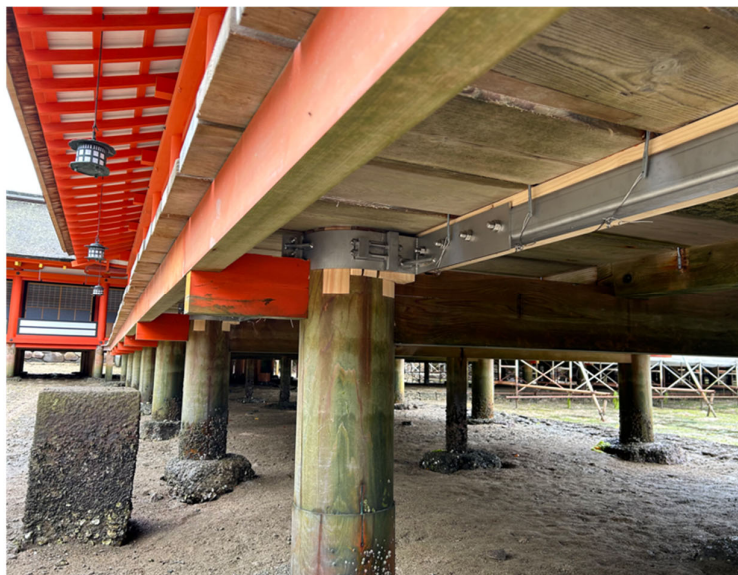
(本社殿回廊耐震補強工事現地状況)
