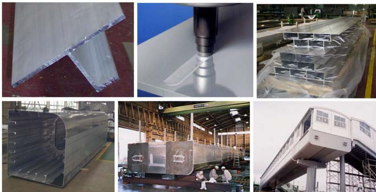
図 5 歩道橋の製作過程 (提供：株式会社 住軽日軽エンジニアリング)
