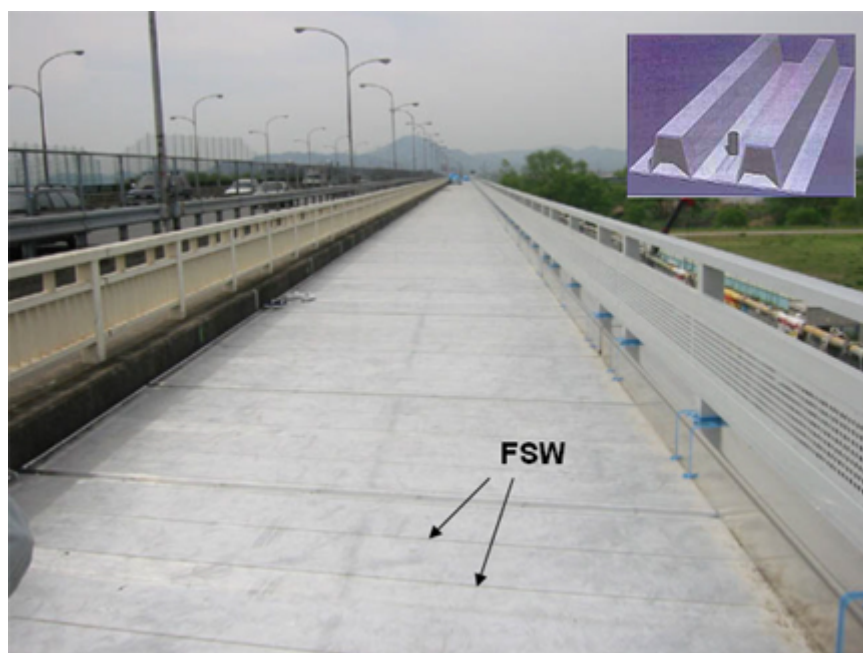
図 6 新加古川大橋 FSW 橋梁床版 (提供：株式会社 住軽日軽エンジニアリング)
