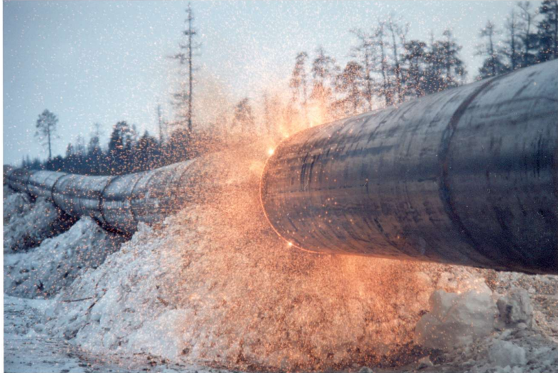
図3 フラッシュ溶接の現地施工状況
