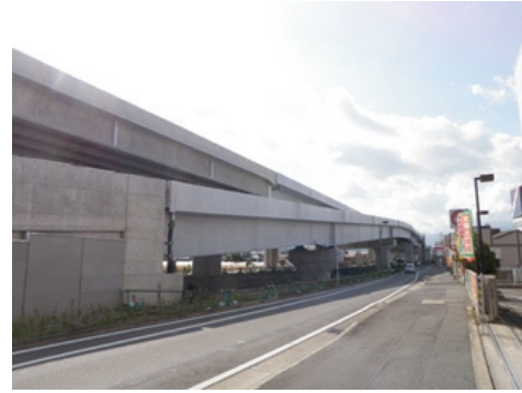
図 16 レーザホットワイヤ溶接適用橋梁 9)
