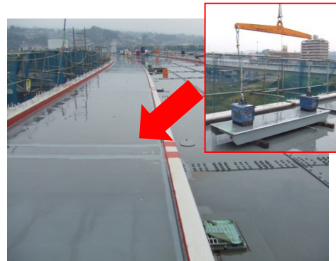
図 13 レーザ・アークハイブリッド適用部材架設状況
