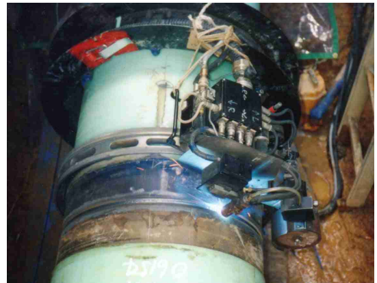
図11 導管での自動溶接
