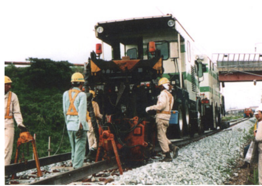
図5 軌道上におけるフラッシュ溶接状況
