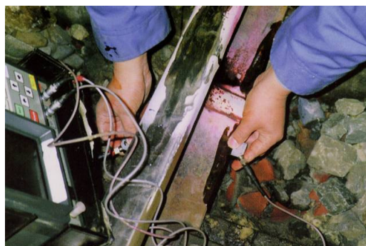
図 10 二探触子法による超音波探傷検査 (テルミット溶接部)
