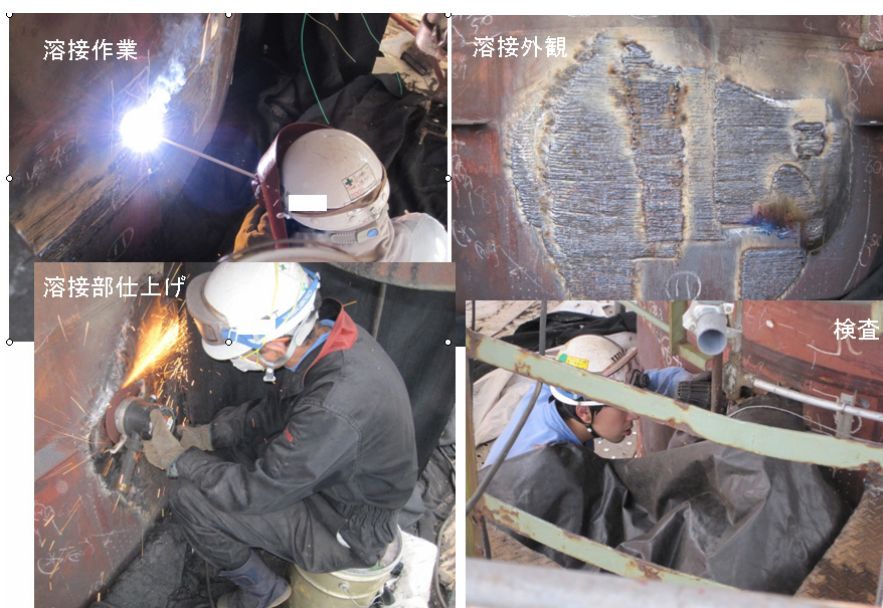
図 11 溶接補修作業の実施状況（外面肉盛溶接、仕上げおよび検査）
